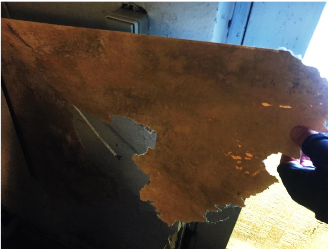
Skimmelbegroninger bag tapet på ydervæg, entre – Aftrykssted nr. 5
