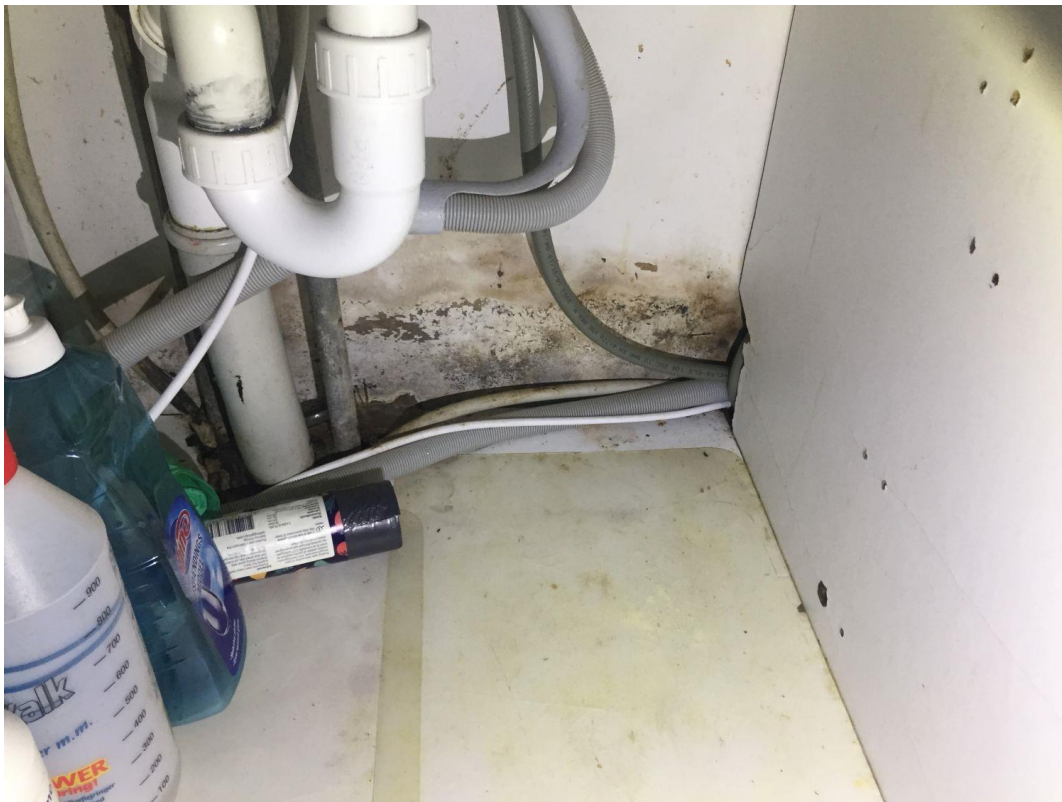
Skimmelbegroninger på bagbeklædning, køkkenmodul
