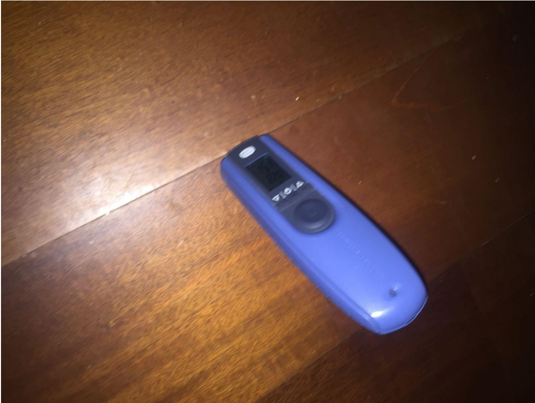
Moderat til kraftigt forhøjet fugtindhold i gulvbelægning, entre
