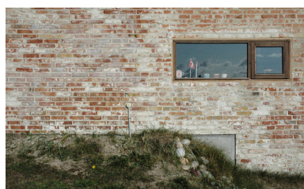
Eksempel på murværk opført i blank mur, hvor der er efterbehandlet med en sækkeskuring, der skaber spil i facaden.
