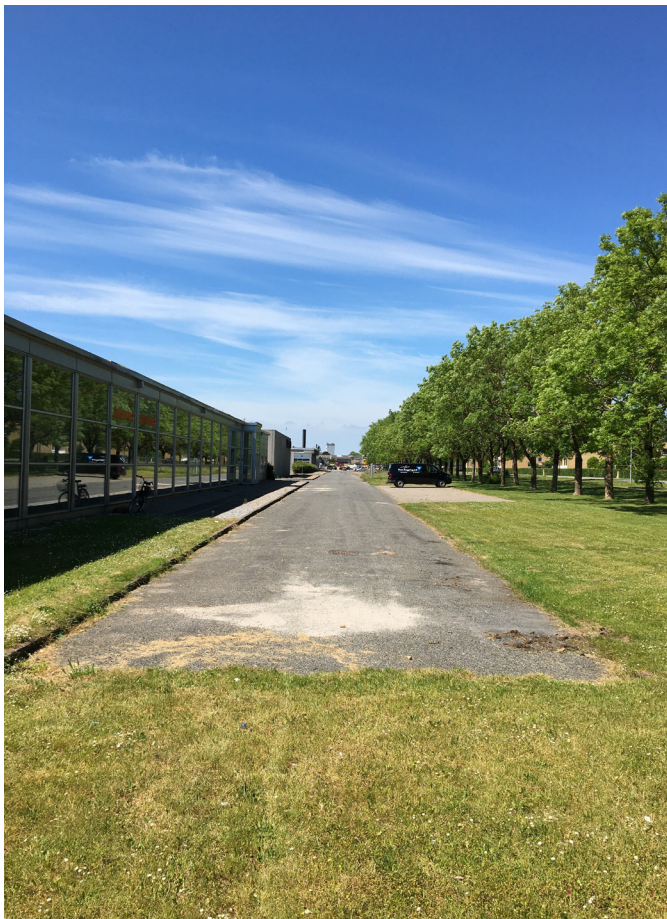
Tranevej med eksisterende bebyggelse og parkering ud mod Køgevej.
