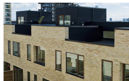
Eksempel på facadeudformning med forskellige højder i den murede base. Sortmalet træ øverst.
