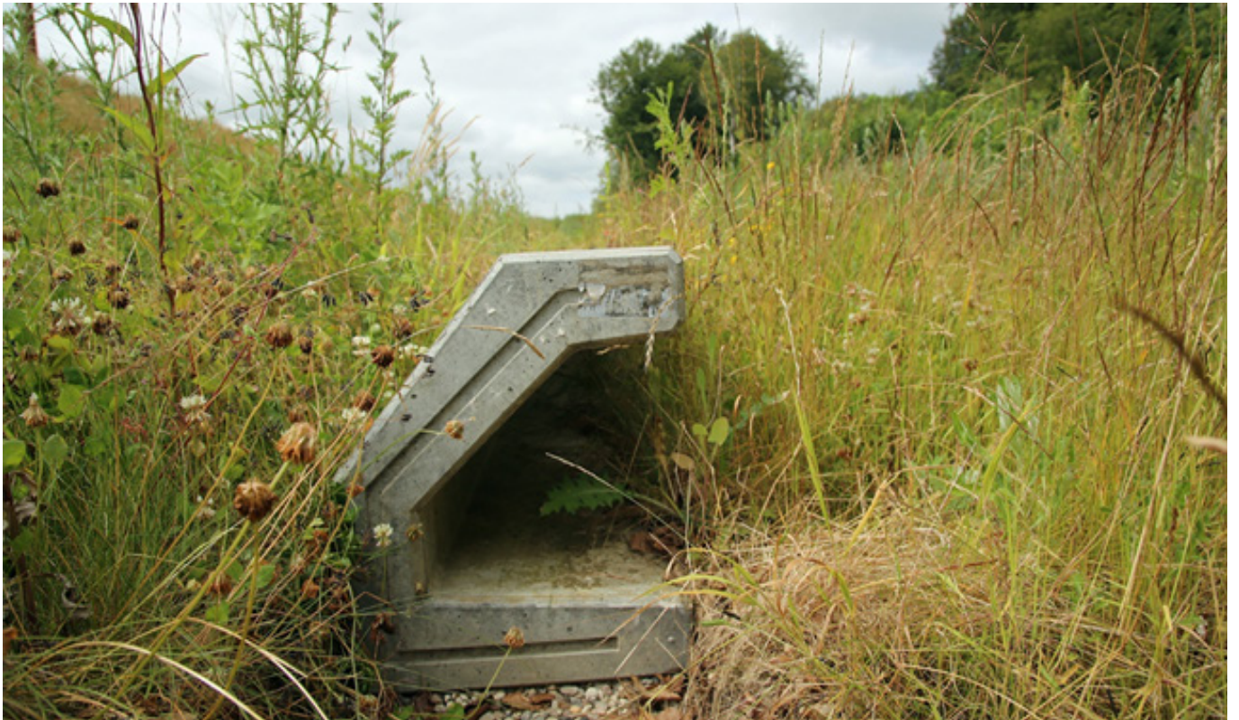
Paddehegn udført i beton
