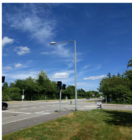
Billedet er et eksempel på et kassearmatur. Der findes flere slags kassearmaturer
