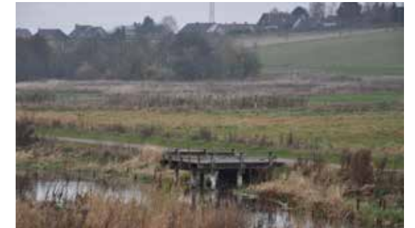
Den eksisterende fiskeplads bibeholdes.
