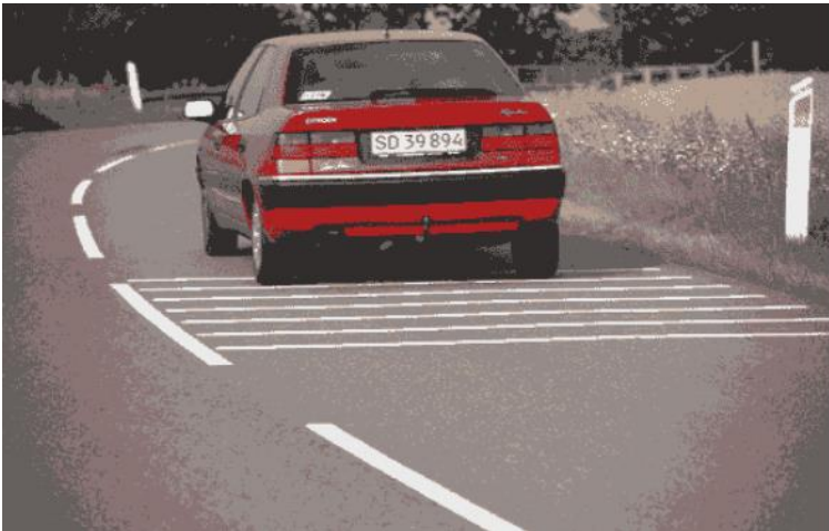
Figur 3: Rumlestriber (Vejreglen "Hastighedstilpasning i åbent land")
