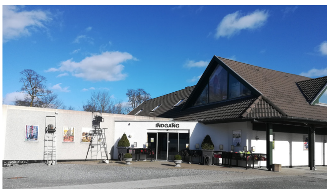
Det eksisterende Indgangsparti til Hubertushuset. Indgangen er placeret hvor boksbebyggelsen og bebyggelsen med saddeltag er sammenbygget.
