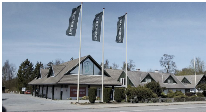
Hubertushuset set fra Roskildevej mod nord. I forgrunden ses 3 flagstænger og på gavlvinduet af bebyggelsen er Hubertushusets logo, men derudover adskiller bebyggelsen sig ikke fra et boligområde.
