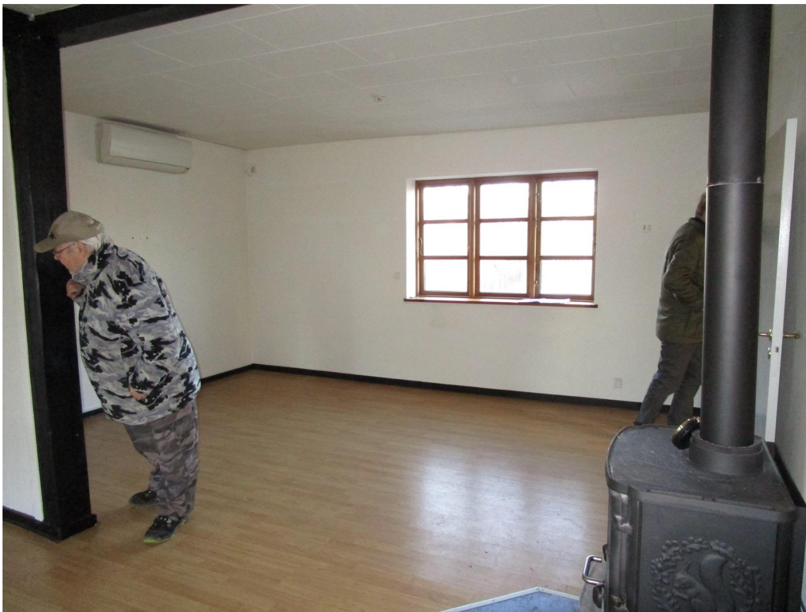
Stueetagen – stuen – luft til luft varmepumpe til opvarmning af stueetagen
