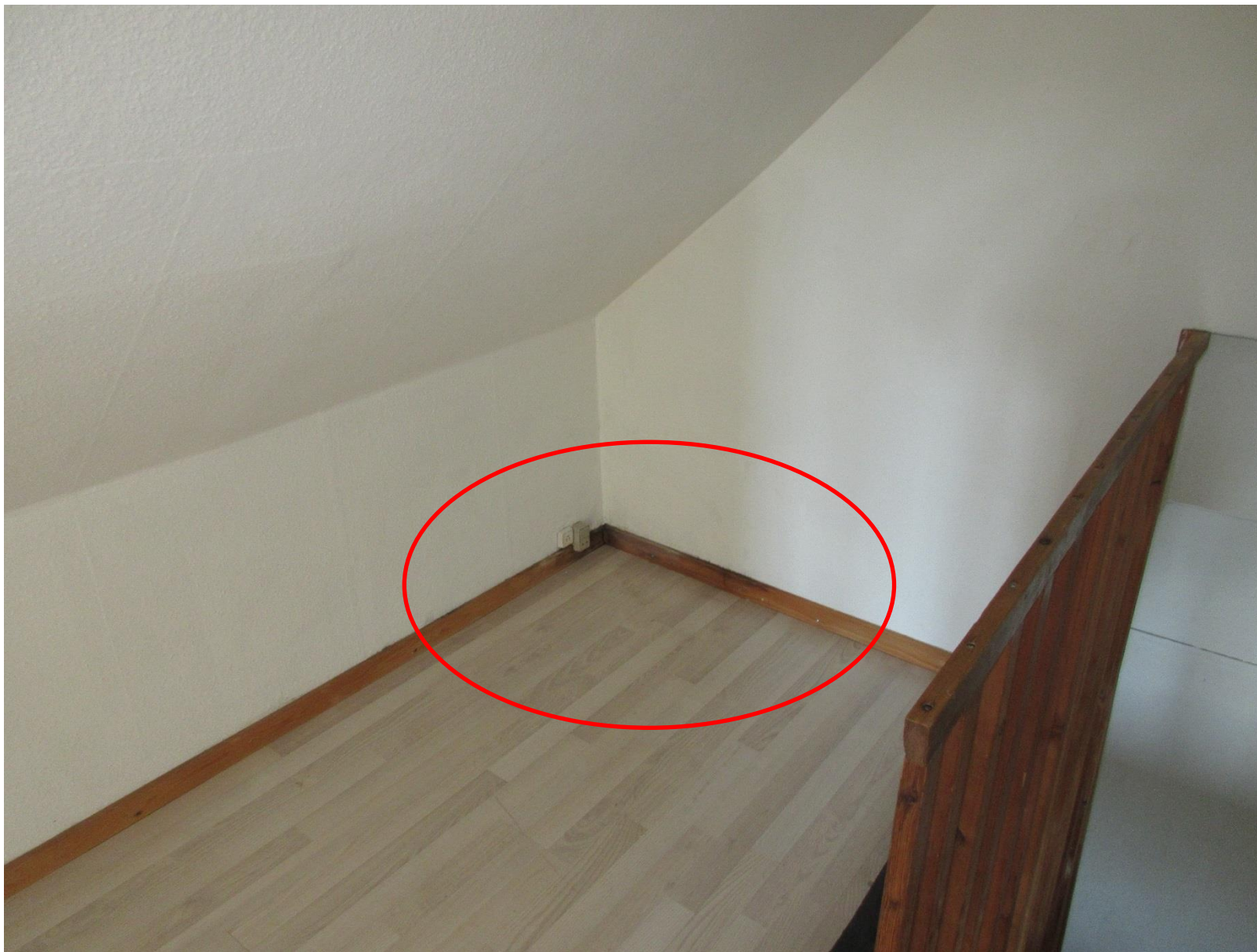
1 sal – repos – synlig skimmel i hjørnet mod soveværelset
