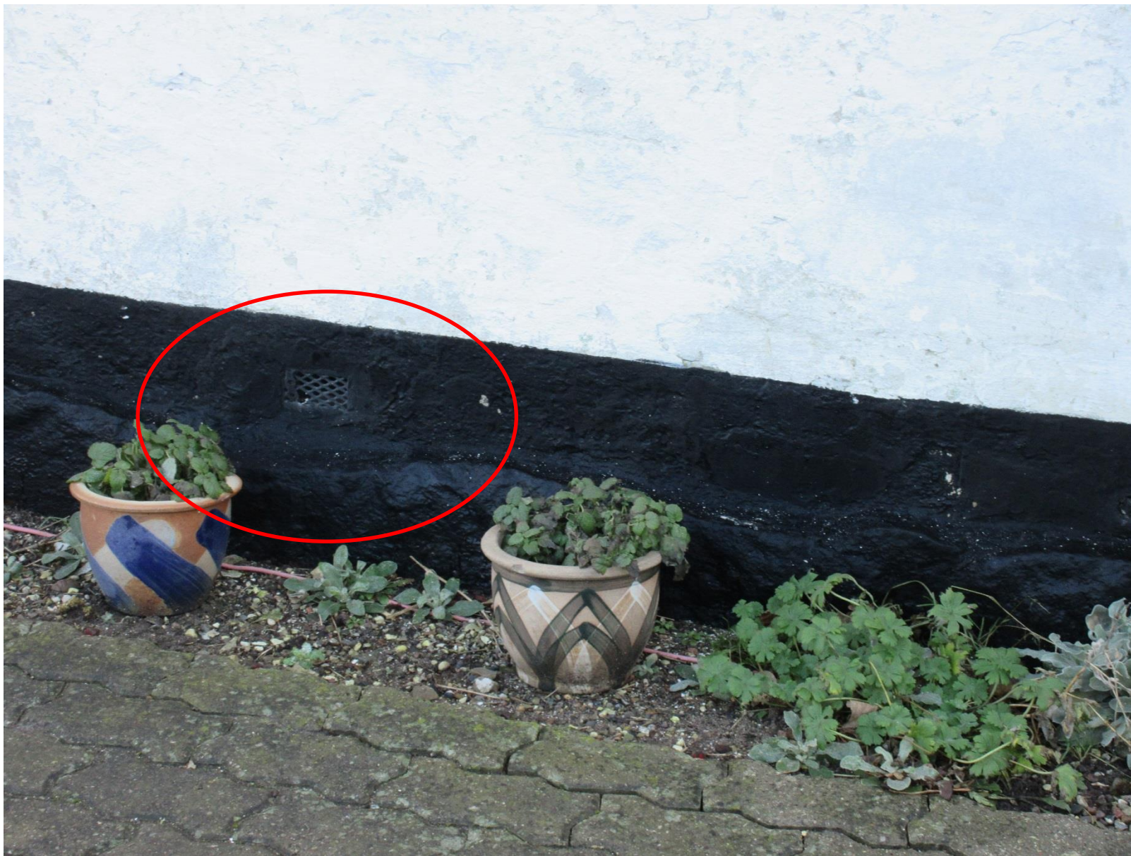
Ventilationsrist til krybekælder er for lille, dvs. mindre end 10x15 cm
