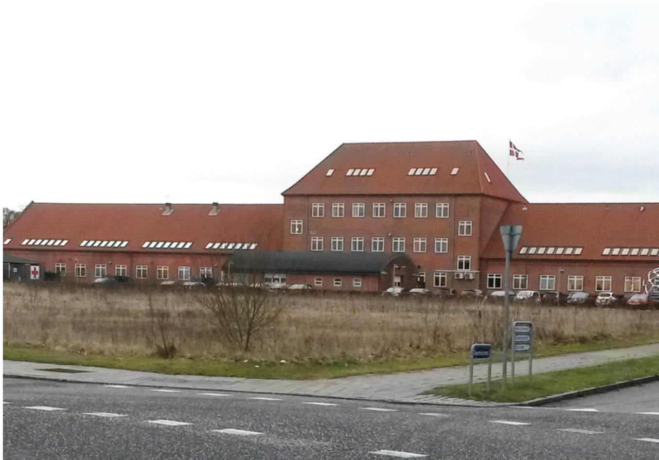
Ringsted Kaserne med lokalplanområdet i forgrunden, set fra Kaserne Parkvej.
