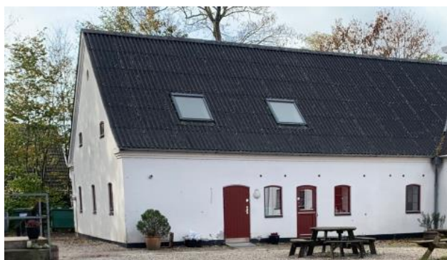
Eksisterende opvarmede længebygning som skal kobles sammen med ny hovedbygning
