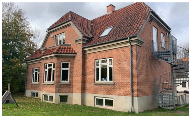
Eksisterende hovedhus der nedrives
