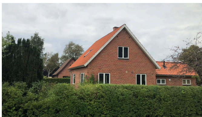
Parcelhus langs Skjoldenæsvej, udført i røde tegl med sadeltag, opført i 1950.
