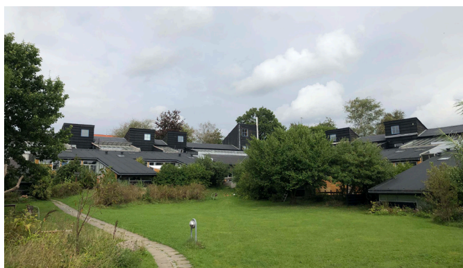
Bofællesskabet Savværket udført med træbeklædning og sort tag i tagpap.
