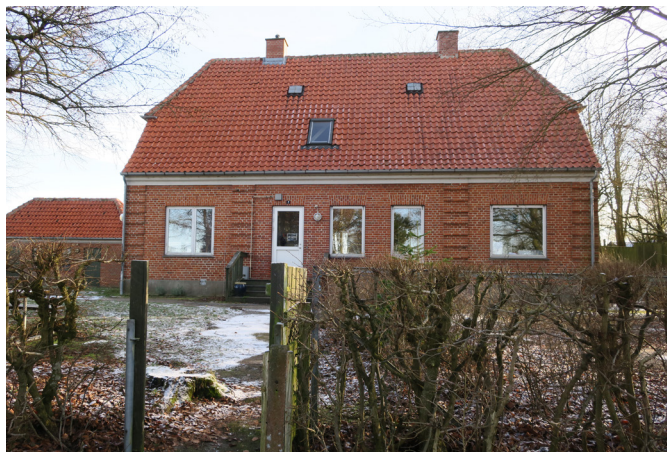
Snekkerupvej 2 - bedre byggeskik og bevaringsværdi 4
