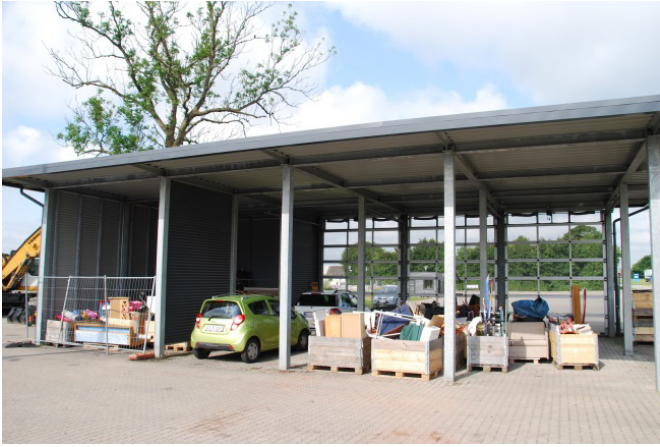
Det overdækkede område på højre hånd ved indkørsel til genbrugspladsen.
