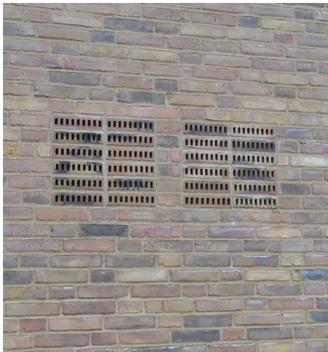
Eksempel på teknisk anlæg hvor afskærmning er integreret
