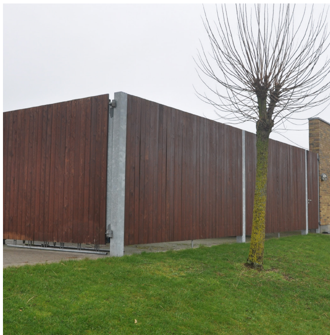
Eksempel på lukket hegn med bærende dele i metal
