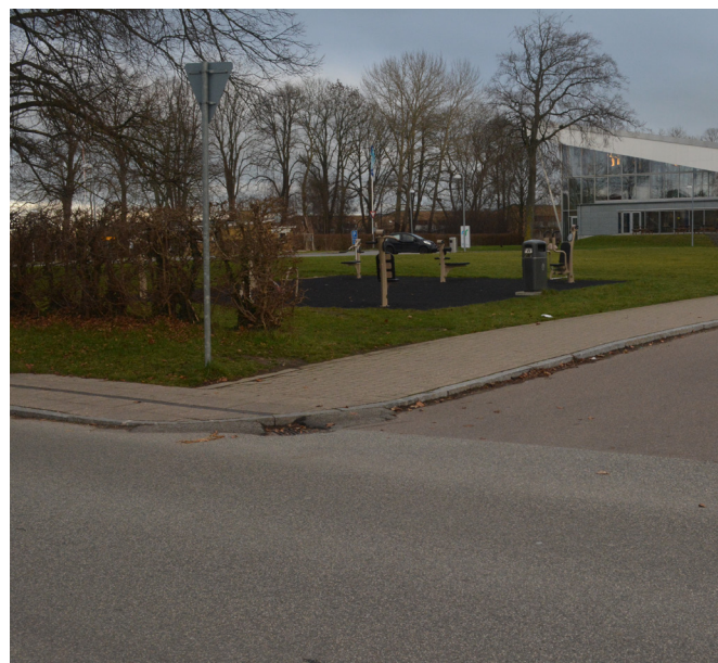
Fortov afbrudt ved overkørsel
