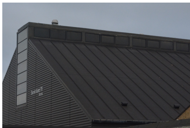
Eksempel på tagpaptag med listedækning
