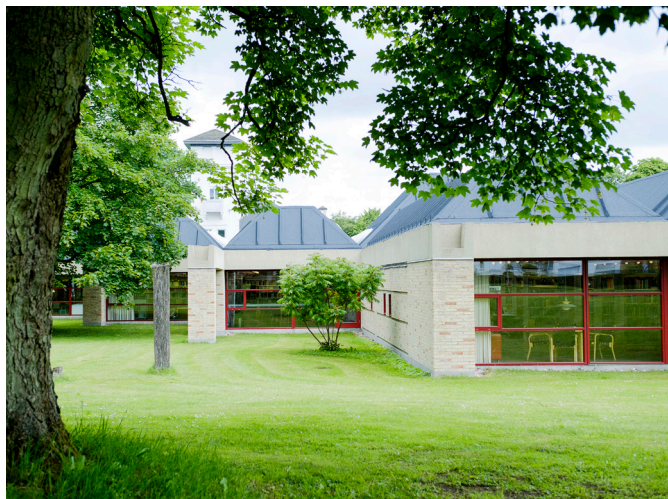
Bevaringsværdi bygning - Tværallé 1-3 (biblioteket). Værdi 3
