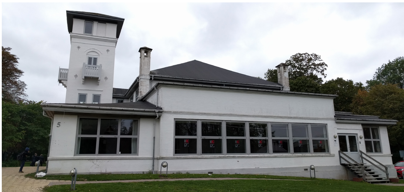
Pavillonen er bevaringsværdi, men er ombygget i modstrid med det originale udtryk. Den skal derfor tilbageføres ved renoveringer og ombygninger
