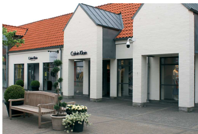
Figur 23: Butiksfacade med Københavertag i rødt tegl og fremspring af gavlkviste med tag i zinkplader
