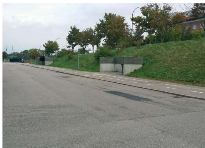
Figur 8: Græsbelagt støjvold med træer mod Nordre Ringvej
