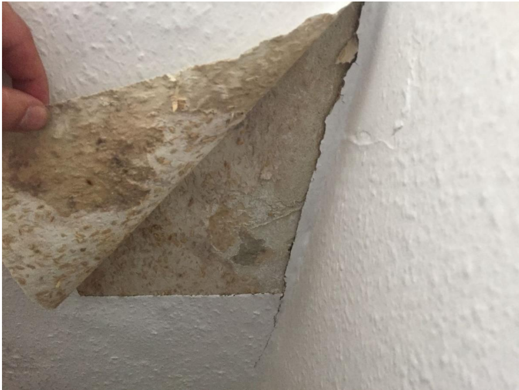
Skimmelvækst bag tapet på ydervæg, stue – Aftrykssted nr. 1
