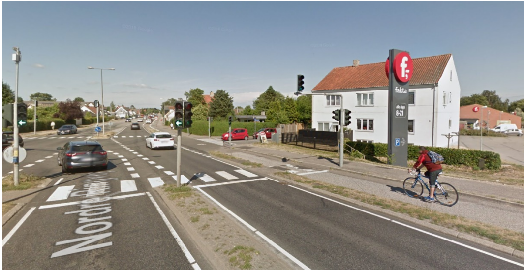
Foto 1: Det foreslås det at fjerne skillerabatten mellem cykelstien og ligeudsporet/højresvingssporet til Fakta på de sidste 50-70 m op mod krydset
