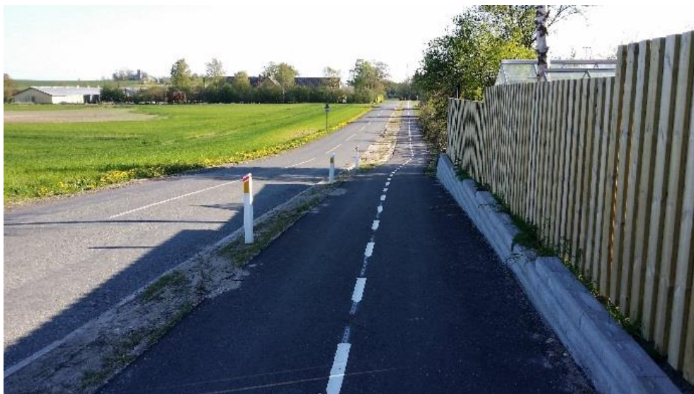
Figur 4-4 Eksempel på smal skillerabat med kantpæle ved Ringsted Ny Friskole på Bringstrupvej. Lodsejer ønskede plankeværk op mod ejendommen.
