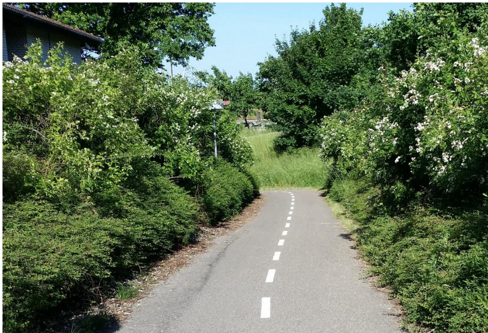
Figur 4-9 Eksempel på dobbeltrettet cykelsti i eget tracé ved rampen ned mod tunnelen under Nordre Ringvej i Ringsted.
