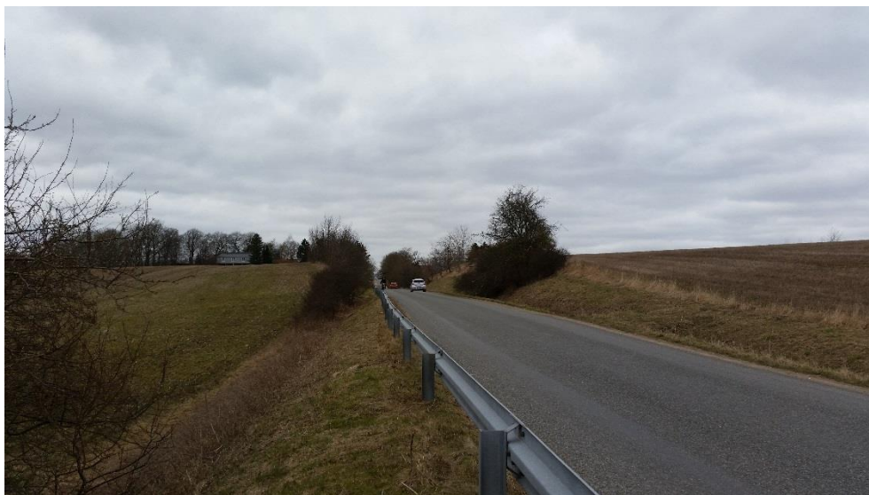
Figur 6-12 Jungsøvej. Her er der autoværn i vestsiden grundet en meget stejl skrænt, hvor niveauforskellen er anslået til 4 m. I modsat side er der en grøft.
