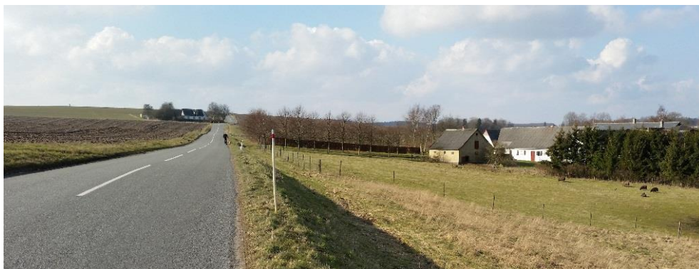
Figur 5-18 Rusgårds Bakke vest for Kildevej set mod vest. Udvidelse i nordsiden kræver opfyldning. Rusgårds Bakke nr. 15 ses til højre i billedet.
