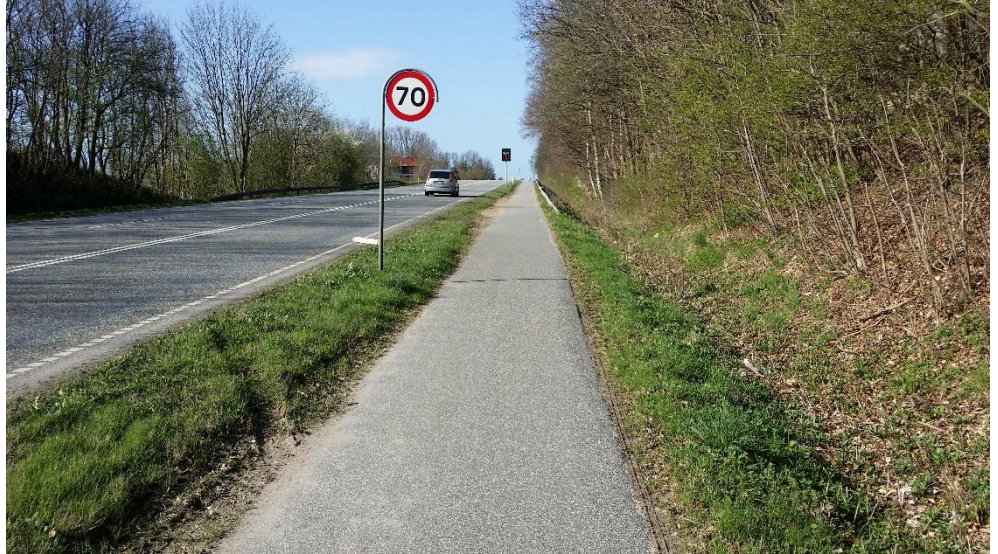
Figur 6-33 Roskildevej set mod syd. Her ændres eksisterende cykelsti til dobbeltrettet cykelsti i vestsiden (til højre i billedet).
