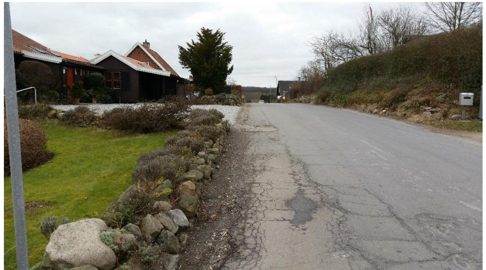
Figur 6-3 Nebsmøllevej set mod vest fra Roskildevej. Asfalten er ca. 5,7 m bred og bredden fra stengærde til stengærde er ca. 6,7 m, dvs. der er plads til en 2 minus 1 vej. Belægningen af kantbanerne bør være jævn i form af f.eks. pulverasfalt.
