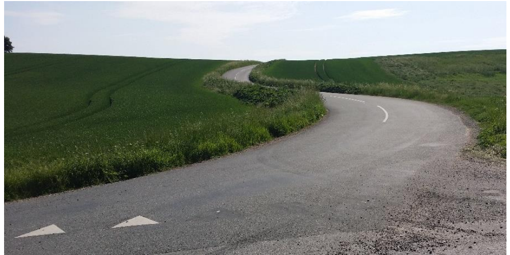
Figur 5-23 Rusgårds Bakke set mod øst fra Værkevadsvej. Bakken er meget stejl, hvilket vil betyde, at stien skal graves ned.
