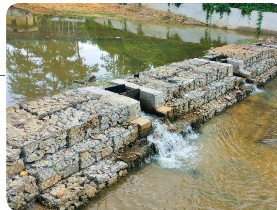
EKSEMPEL PÅ UDFORMNING AF GABION MED "VANDFALDSEFFEKT"
