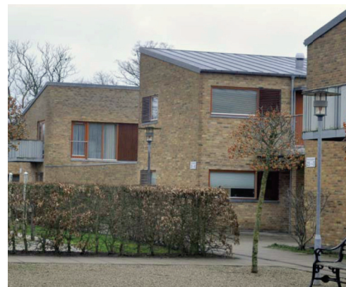
TAGE: Den nye tilbygning følger længderetningen på det eksisterende center. Skrånede tagflader beklædes med stålplader som eksisterende
