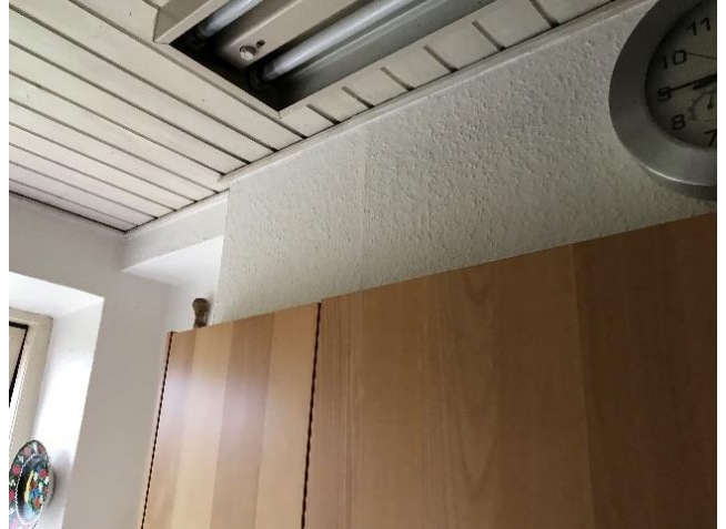
Inddækning af rørinstallationer
