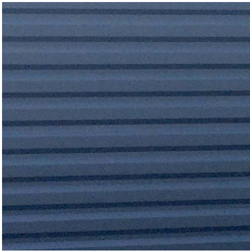
Eksisterende facade, sorte stålplader, Hal A
