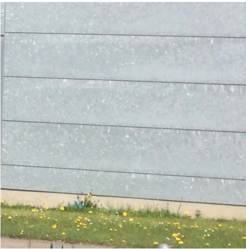
Eksisterende facade, grå galvaniserede stålplader Svømmehal
