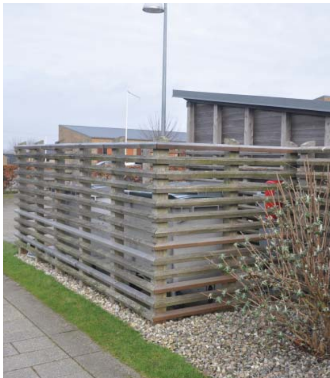
Afskærmning omkring affaldsstation
