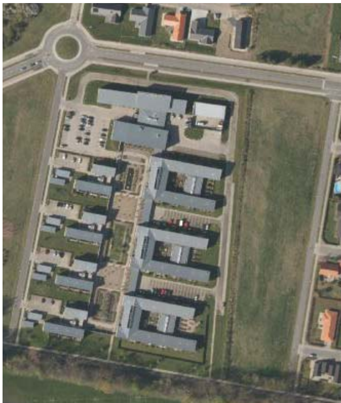
Eksisterende bebyggelse som primært er udført som øst-vestgående længer med enkelte tværgående bygninger
