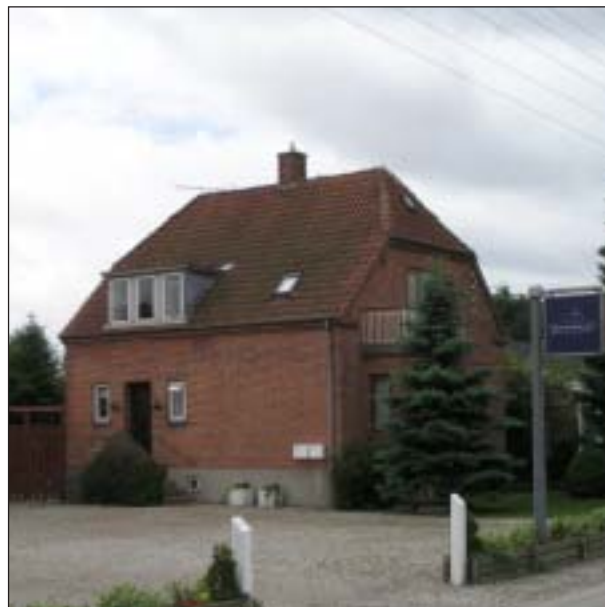
Eksempel på ejendom med middel bevaringsværdi.
