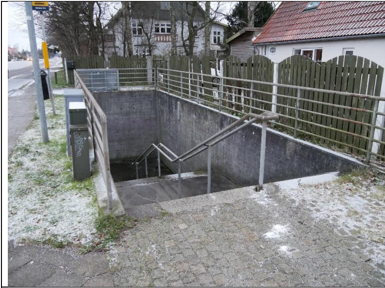
Nedgang syd øst for Roskildevej ved Østervej.
