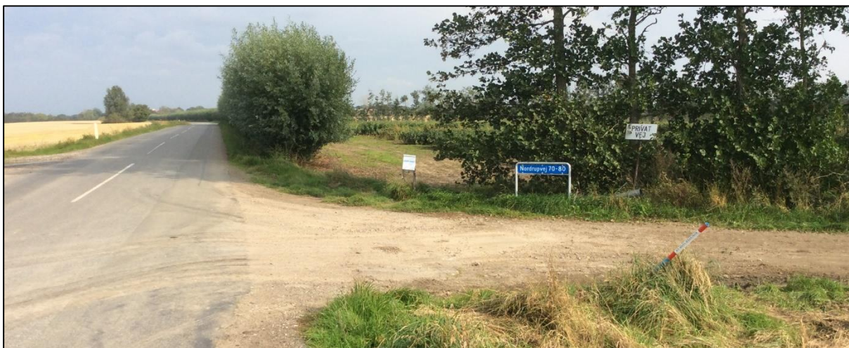
Figur 4: eksempel på eksisterende læhegn som kan nedsætte oversigten ved udkørsel fra Nordrupvej 70 – 80
