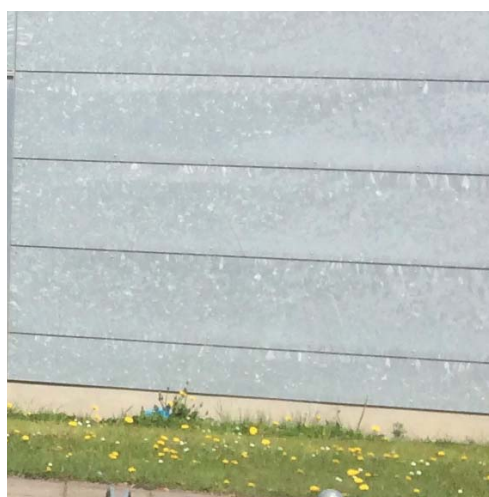
Eksisterende facade, grå galvaniserede stålplader Svømmehal
