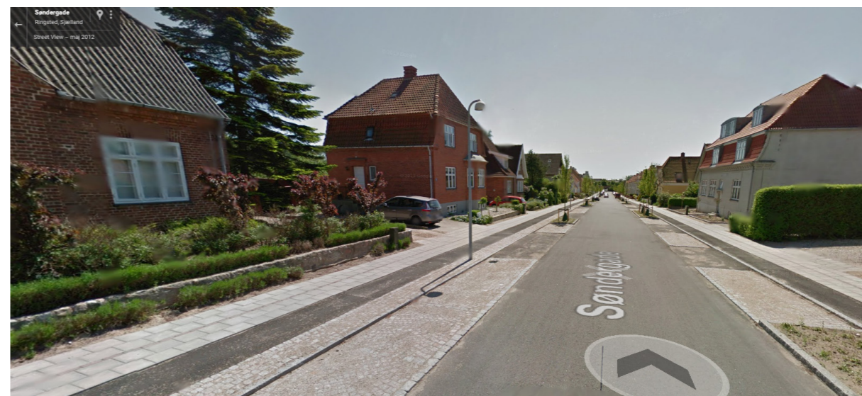
Referenceprojekt fra Søndergade med længdeparkering i chaussesten i buforbandt, med kant mod asfalt i 1 skifte granitbrosten.
