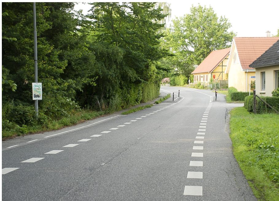
Figur 2. Eksempel på '2-1' vej med fartdæmpning på selve strækningen.
