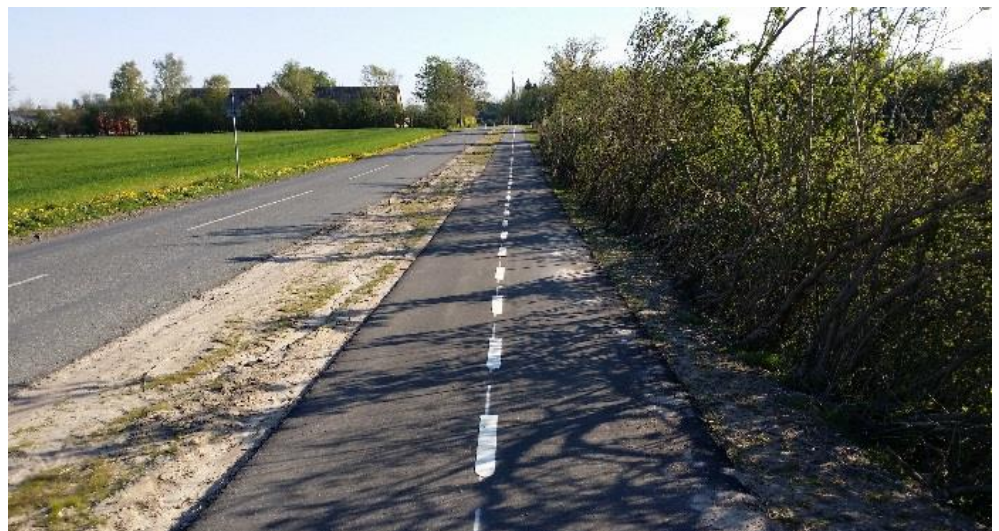
Figur 4-1 Eksempel på ny dobbeltrettet cykelsti langs vestsiden af Bringstrupvej. Der vil blive sået græs i skillerabatten for at undgå, at grus fra rabatten ender på stien til gene for cyklister og gående.
