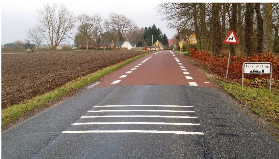
Figur 4-6 Eksempel på hastighedsdæmpning (rumlefelte på tværs af kørebanen) ved en byzonetavle, hvor 2 minus 1 vejen i Tvindelstrup starter. Billede fra Vejdirektoratets rapport om 2 minus 1 veje, COWI.
