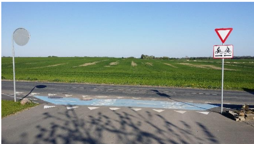
Figur 4-2 Eksempel på skiltning og afstribning af blåt cykelfelt ved Ringsted Ny Friskole på Bringstrupvej.
