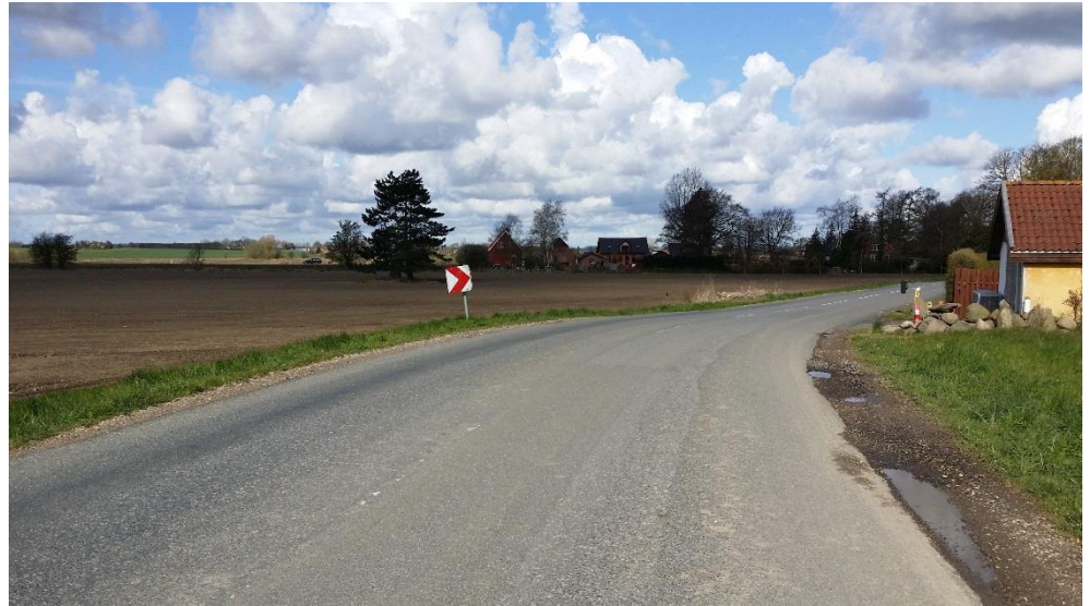
Figur 5-18 Stien i eget tracé i det røde scenarie vil forløbe fra Nordrupvej mod vest ca. fra tavlen mellem det høje træ midt i billedet og bygningerne i baggrunden (set mod vest).
