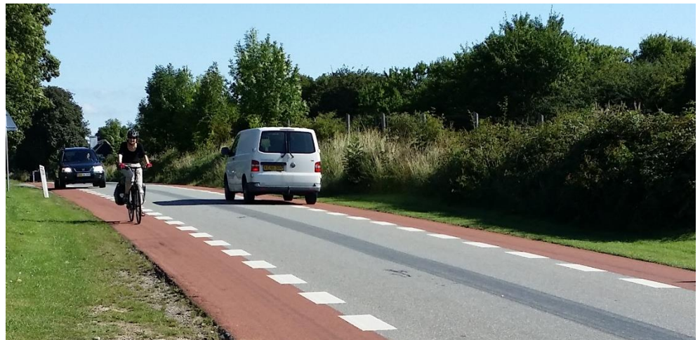
Figur 4-7 Eksempel på 2 minus 1 vej ved Præstøfjord. Billede fra besigtigelse sept. 2016, COWI. Billedet viser korrekt adfærd ved mødesituation hvor køretøjerne trækker ud på den røde kantbane og bilen til venstre i billedet sætter farten ned for at afvente mulighed for at overhale cyklisten.
