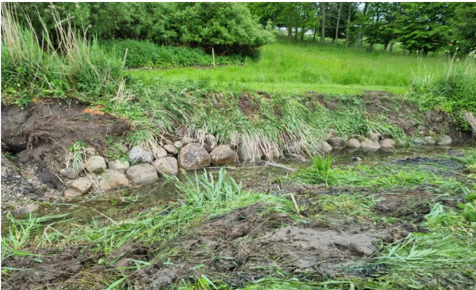
Figur 21. Parti med brug af sten til erosionssikring
