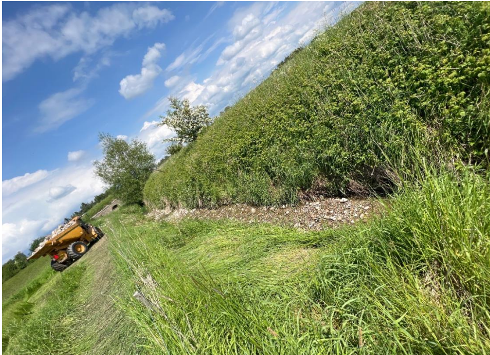
Figur 11. Etablering i gang, med udlægning af groft materiale
