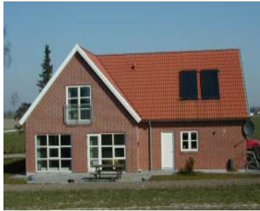
Solfanger monteret på tagkonstruktion
