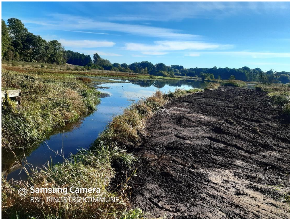
Figur 37. Eksempel på opfyld af kanal (mørkt parti med bar jord).
