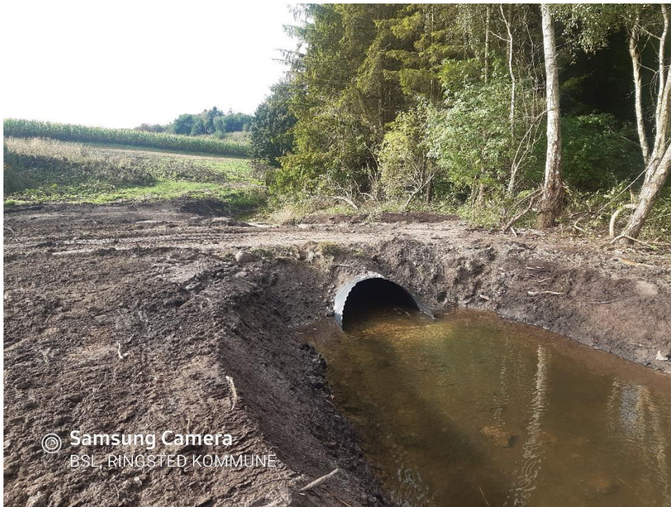
Figur 24 Etableret rørbro i skovkanten
