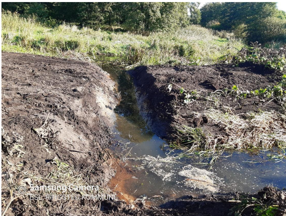
Figur 38. Frigravning af ét af de to dræn på matr. 14æ
