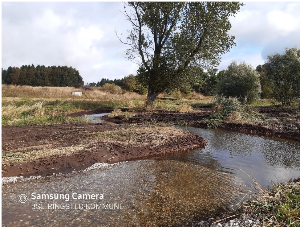
Figur 30. Del af slyng, samt udlægning af materiale
