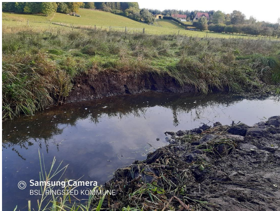
Figur 46 Parti med afgravning af brink, samt udlægning af sten
