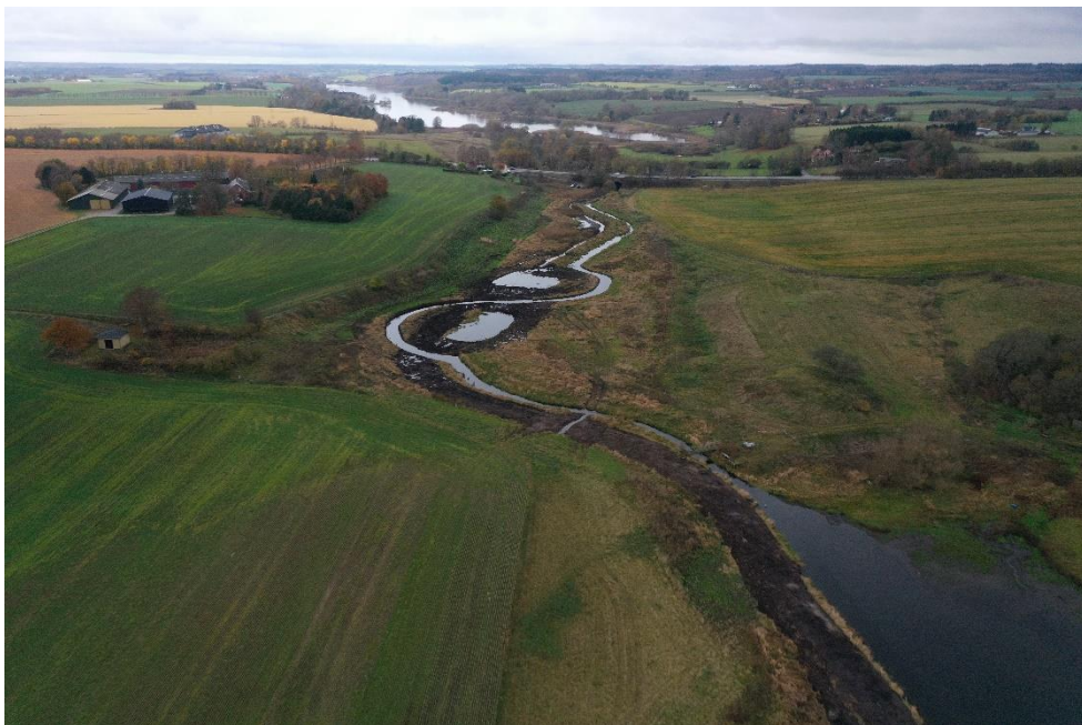
Figur 36. Efter: Vandløb og kanal nær Roskildevej efter genslyngning, etablering af paddehuller, samt opfyld af kanal. Opfyld ses som mørke partier i landskabet og 2 paddehuller som små søer i det gamle trace.
