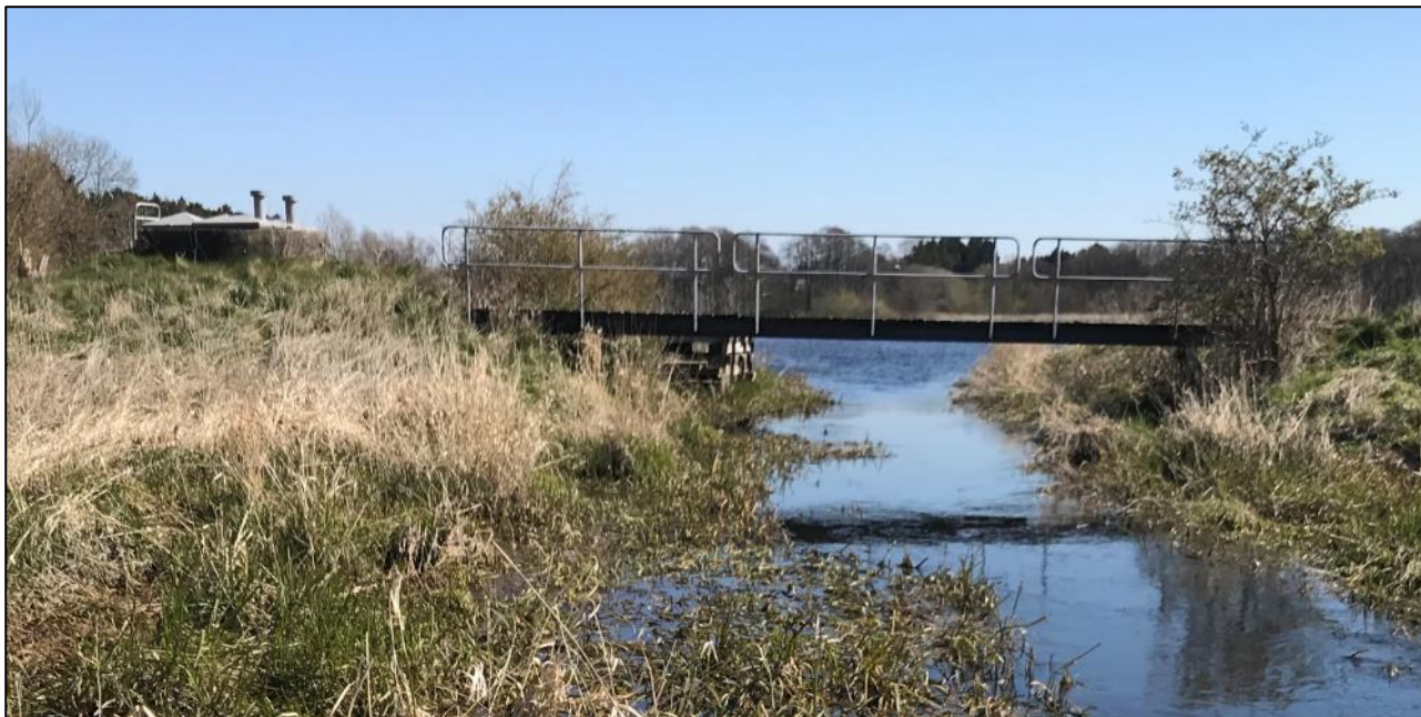
Figur 15. Pumpestation med tilhørende rørudløb og spang.
