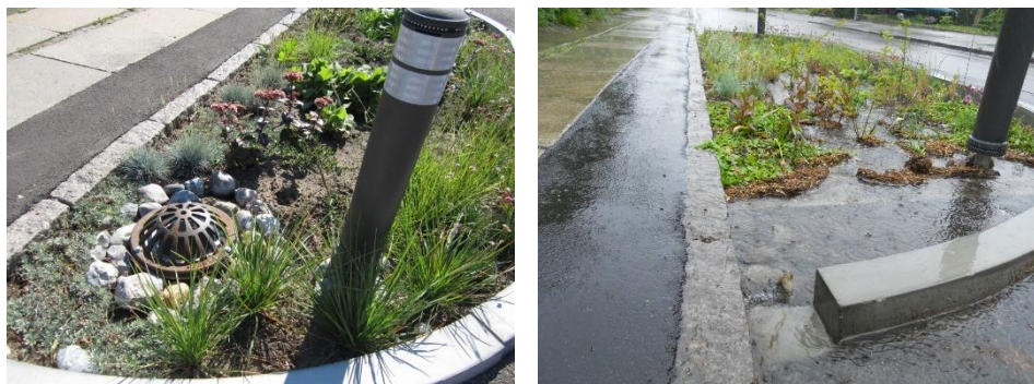
Figur 7 Regnbede i tørvej og regnvej. Kuppelristen fungerer som overløb til den underliggende rende, når det regner mere end regnbedet kan nå at nedsive.
