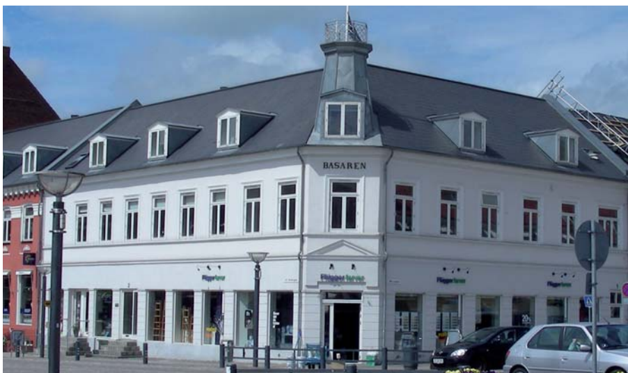
Ejendommen er et smukt eksempel på facaderenovering med udgangspunkt i den oprindelige facade
