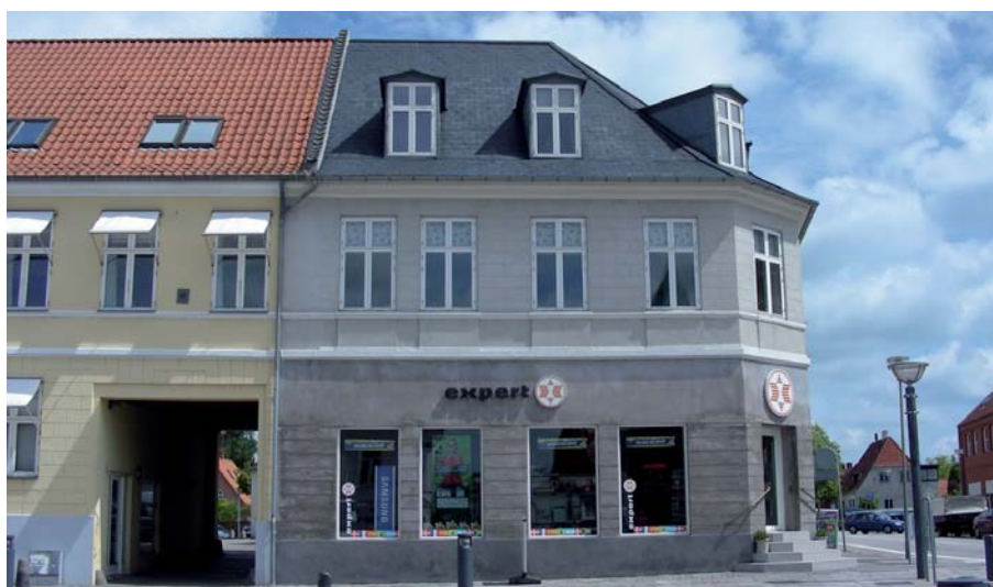
Et fint eksempel på at facaderytmen og vinduernes fagdeling er forsøgt fastholdt ved ombygning
