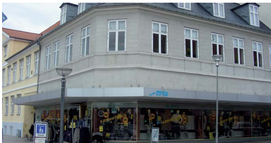
Der er stadig enkelte steder i bymidten hvor der er opsat baldakinere på ejendommen. På side 11 er ejendommen vist nyrenoveret og uden baldakin
