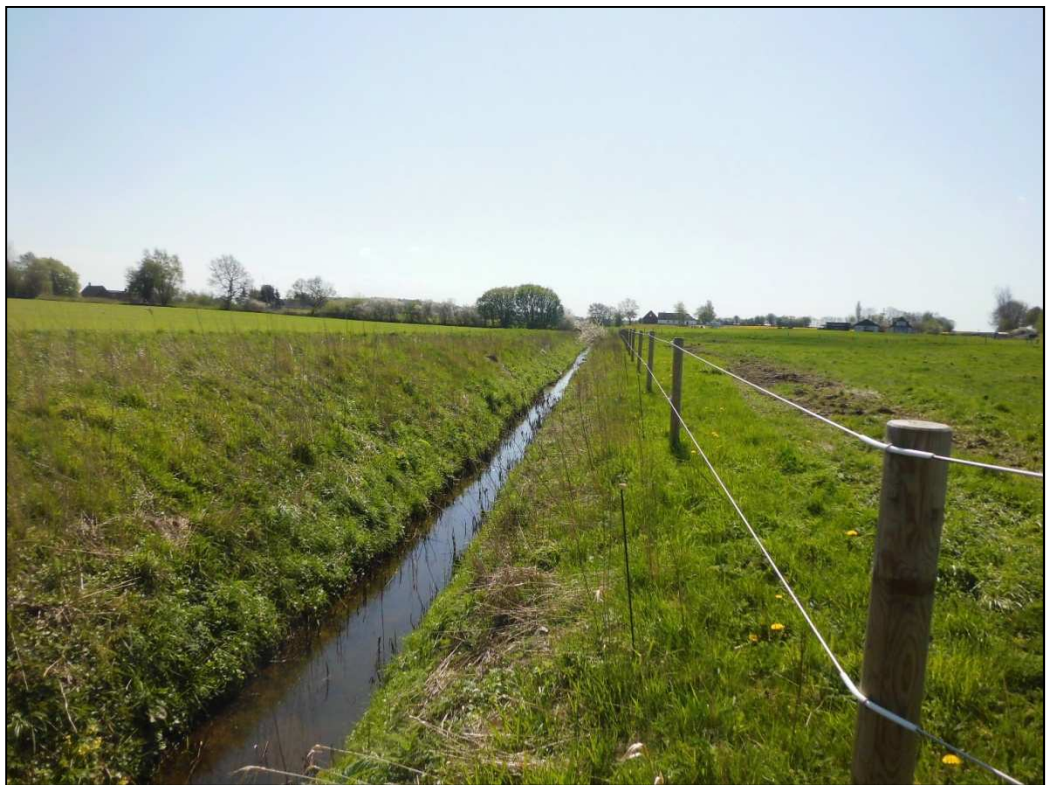
Figur 1.1.: Modstrøms i retning af rørudløb st. 954 meter. Rødder fra tagrør i vandløbsprofil.
