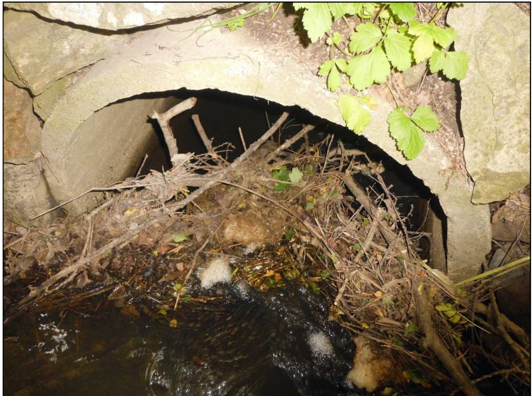
Figur 4.1.: Indløb rør st. 4.242
