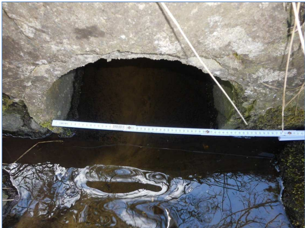
Figur 4.3.: Udløb rør \text{Ø} 45 cm, st. 1.978 meter..
