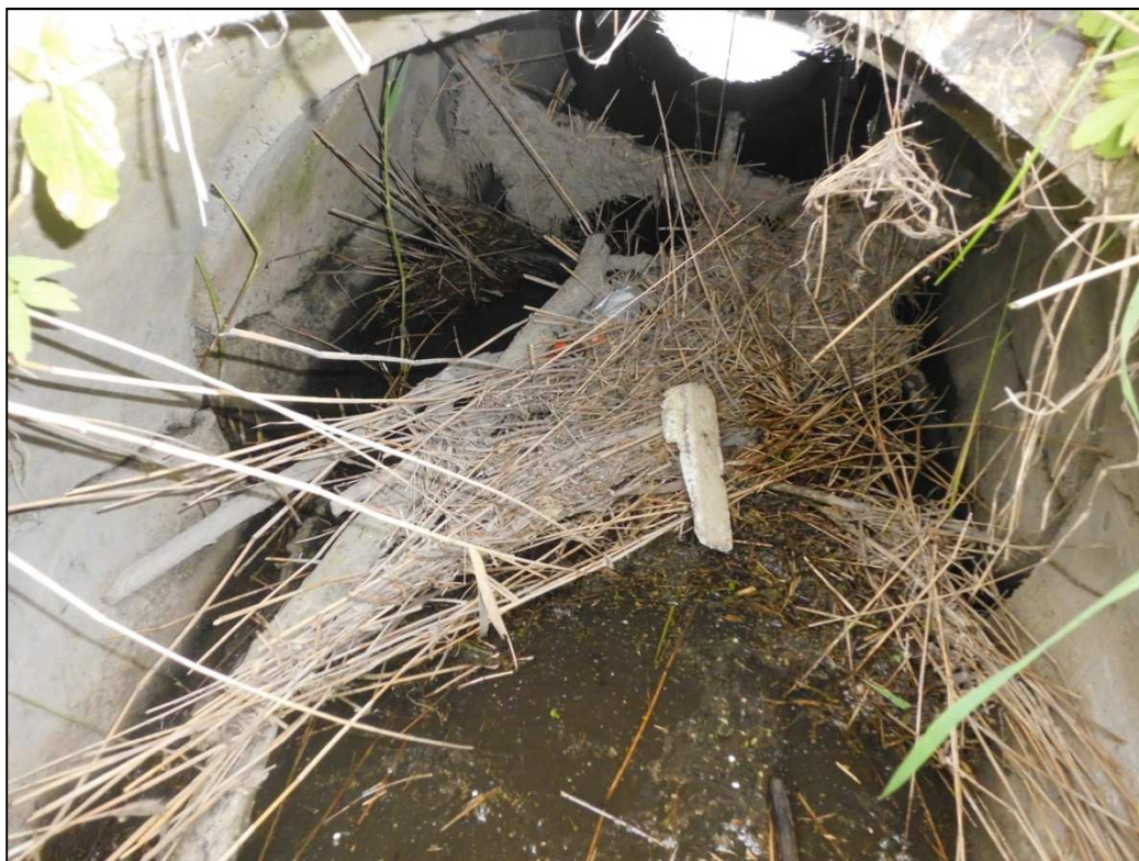
Figur 4.1.: Indløb rør st. 4.873
