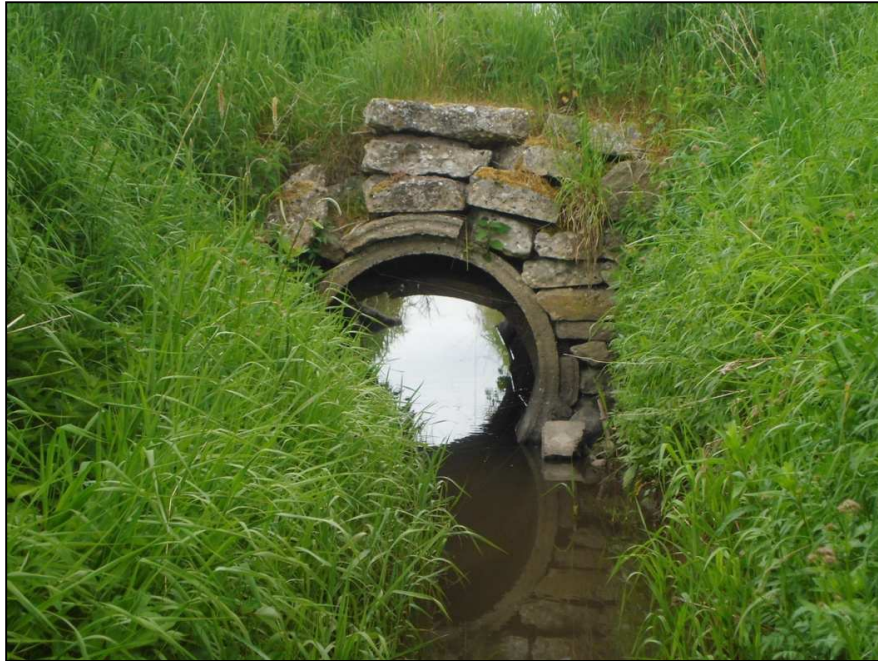
Figur 4.2.: Indløb rør st. 5.577 meter
