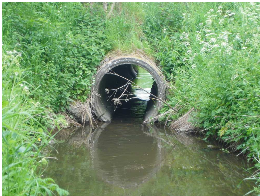
Figur 4.3.: Udløb rør st. 6.291 meter
