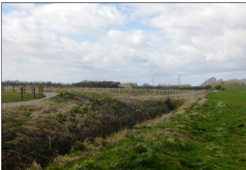
Figur 4.1.: Ved vandløbssving venstre, bro st. 1.501 meter.
