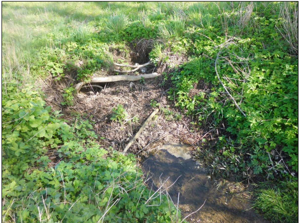
Figur 2.2.: Rørindløb st. 97 meter – ikke målt.
