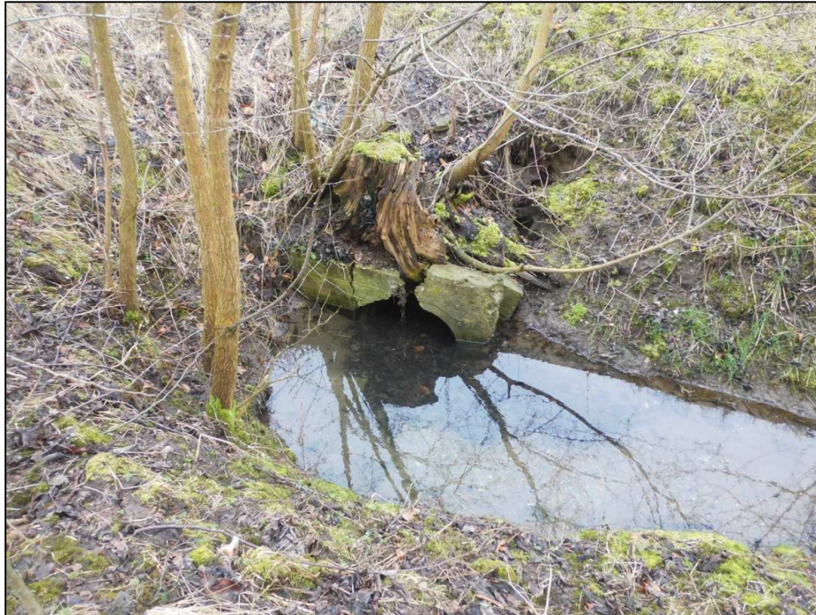
Figur 4.2.: Udløb rørunderføring ved Køgevej.
