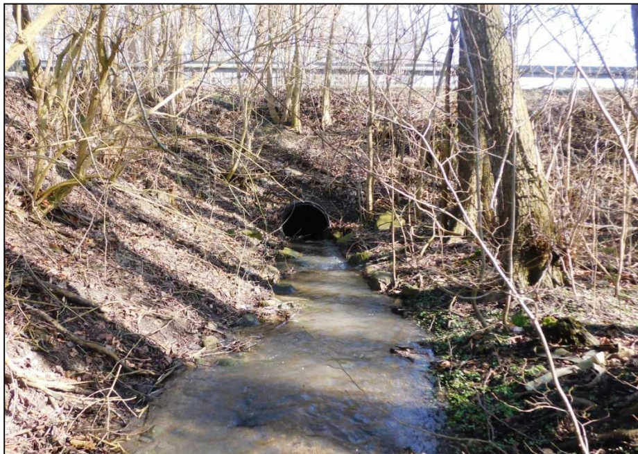
Figur 4.3.: Ny rørunderføring st. 2.763 meter
