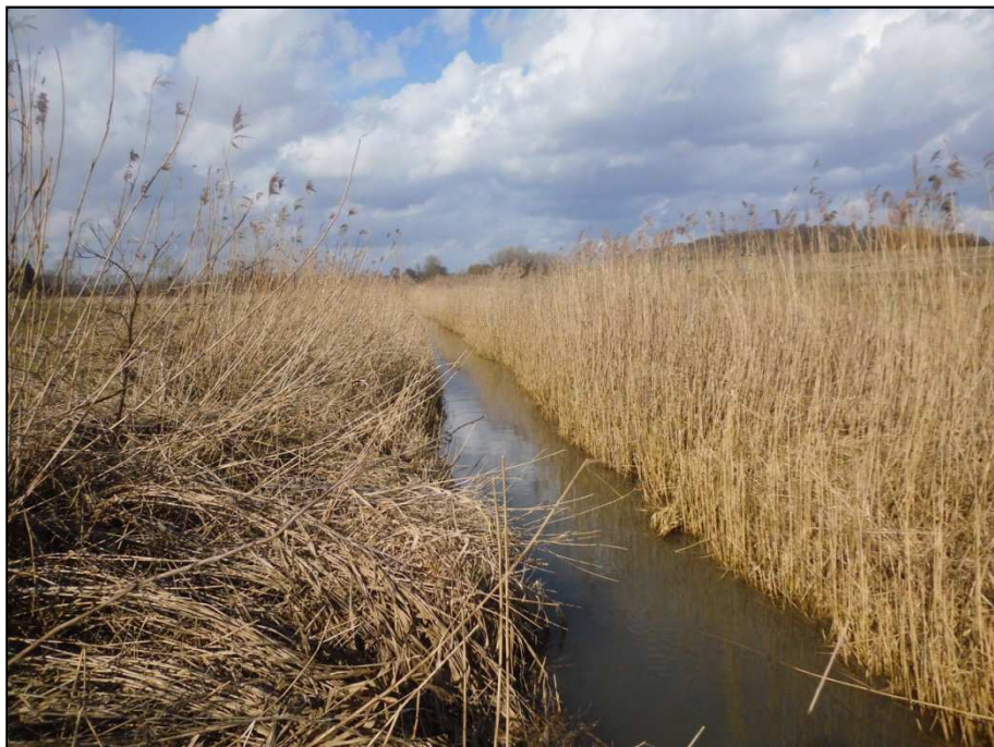
Figur 4.5.: "Pumpebassin" opstrøms st. 2.479 meter
