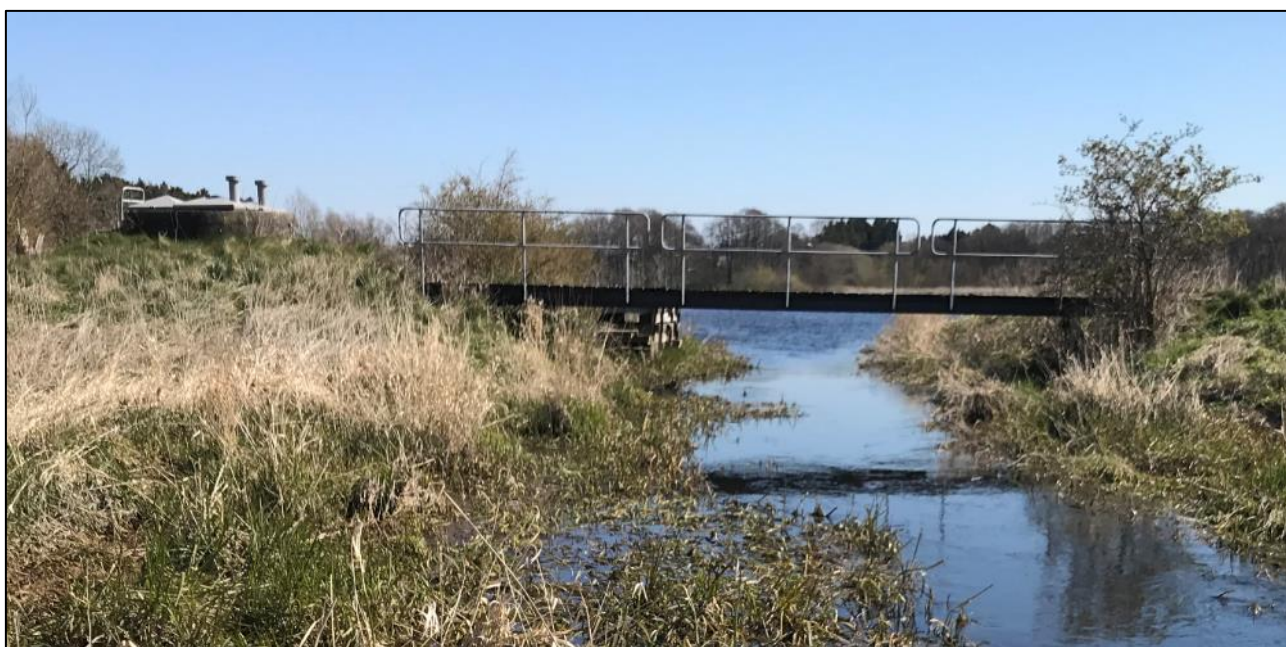
Figur 15. Pumpestation med tilhørende rørdløb og spang.
