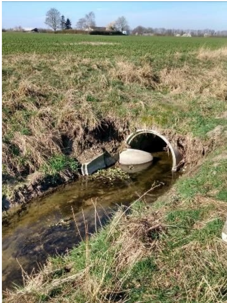
Foto 1. Vognsbækken Øverst venstre: st. 2950 godt fald og mange sten, øverst højre: st. 2469 Overkørsel, der er ved at falde sammen, sandaflejringer. Nederst venstre: st. 2400 langt lige stykke uden træer til skygge og med få større sten til at skabe variation og skjulesteder. Nederst højre: st 2240 træ, der er med til at skabe skygge og får vandløbet til at slynge.
