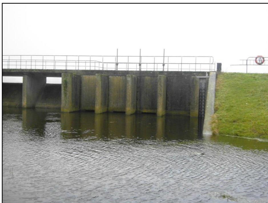
Figur 2.2.: Stemmeværkets tre sluseporte samt måleoverfald og ålepas (til højre).
