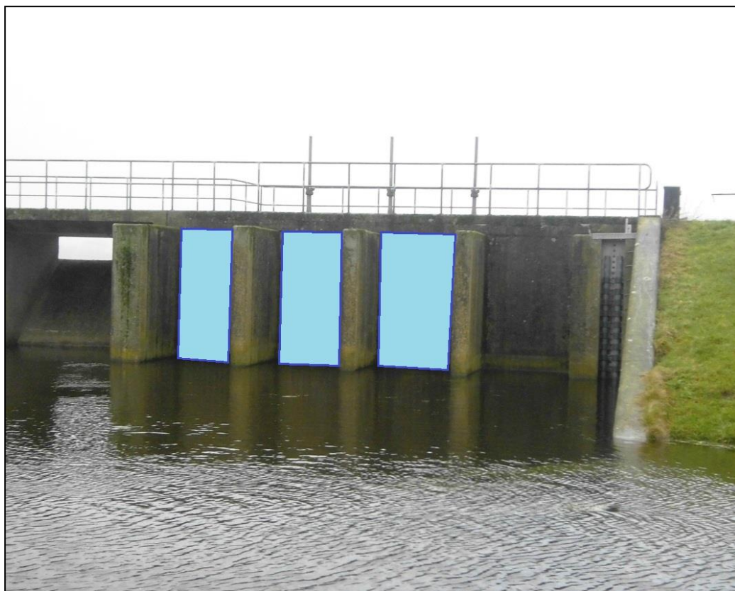
Figur 2.3.: Skitse af nedbrydning af mure ved sluseporte.
