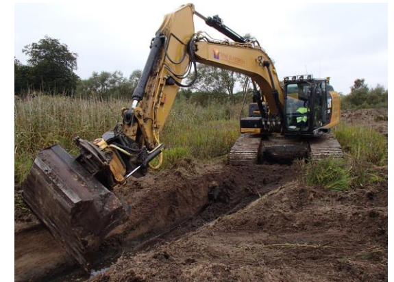
Gravearbejde i forbindelse med regulering af et åforløb
