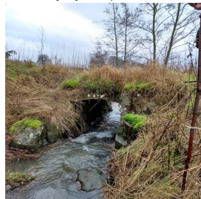
Foto 1: Overkørsel i st. 4790
