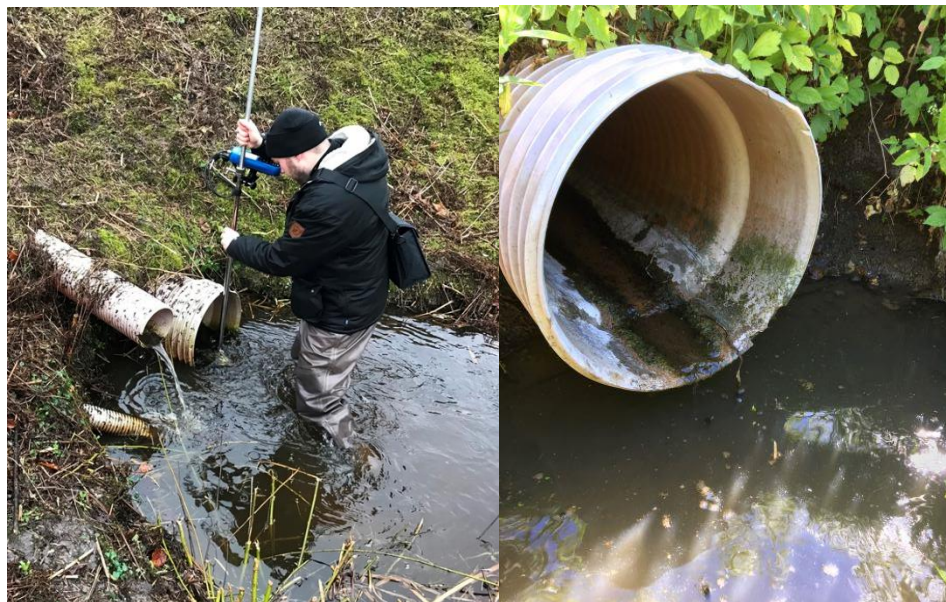
Figur 6.3: Afløbet fra søen nedstrøms Skjoldenæsvej, ved høj vandføring (tv.) og lav vandføring (th.). Begge fotos er fra 2018.
