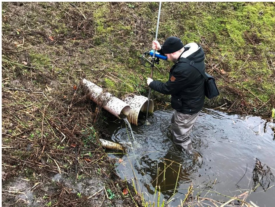
Figur 2.7: Udløb fra Skjoldenæsholm Gårdsø. Udløbet er det store af rørene vist på fotoet. De to øvrige er dræn og vejvand, formentlig med tilkøbet spildevand (baseret på lugt og udseende). Foto af 31.01.2018.
